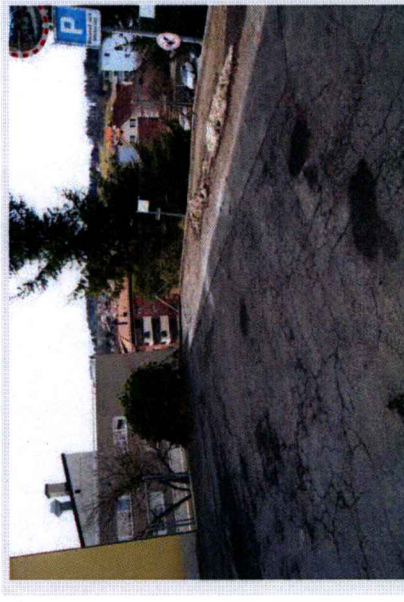
Places de parc, dégâts de l'asphalte
